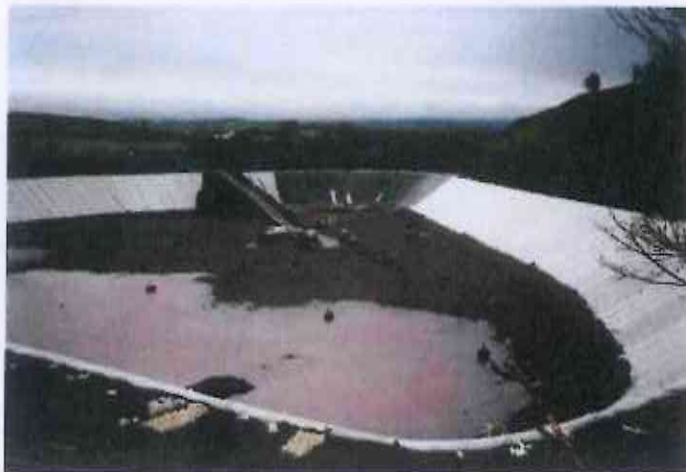
TULLYVAR LANDFILL SITE – OVERVIEW
